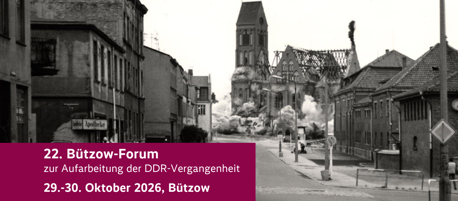
Foto: Bildarchiv Heinrich-Theissing-Institut. Sprengung der Rostocker Christuskirche am 12. August 1971
